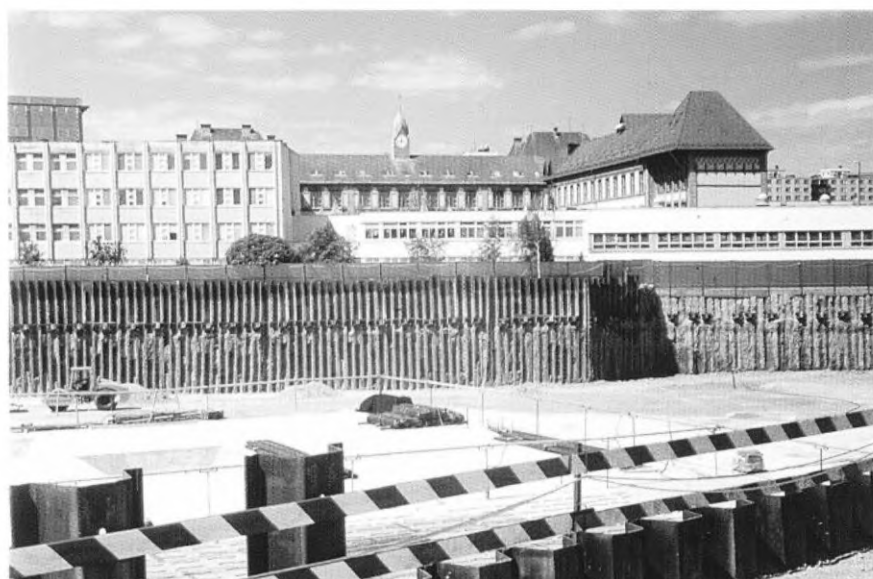
Debrecen történelmi belvárosának maradéka tűnik el a Csapó és Rákóczi utcák környékén, az újabb mélygarázsok és üzletközpont építéskor.
