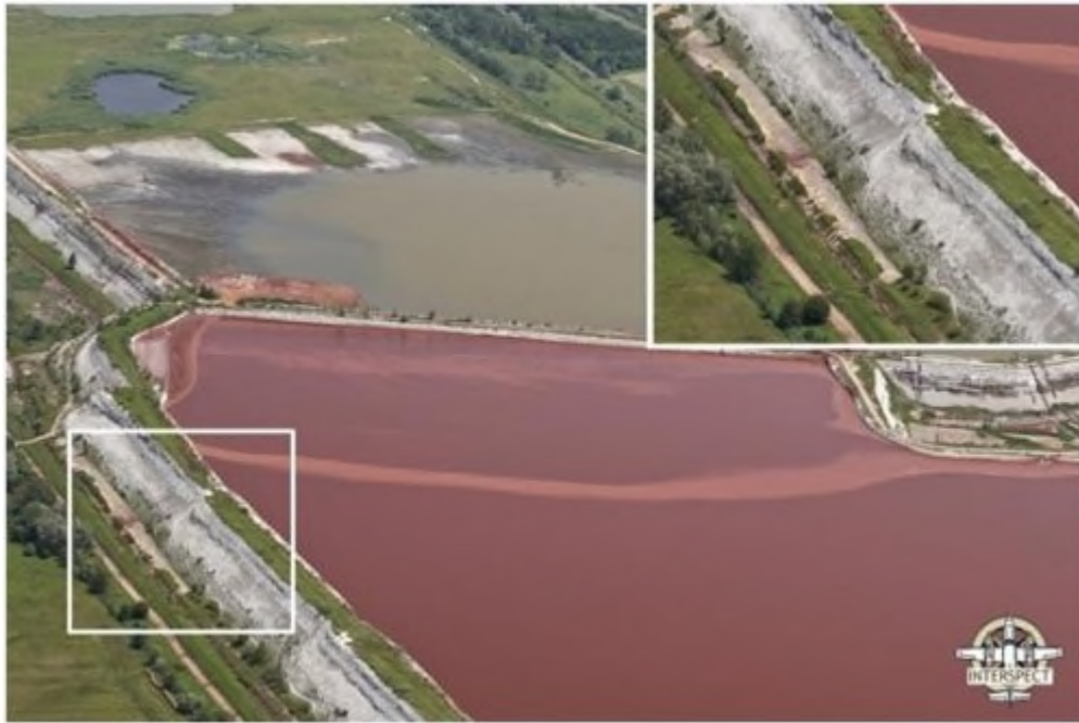
júniusi felvétel: a tározó mellett látható vörös csík komoly szivárgásra utal
