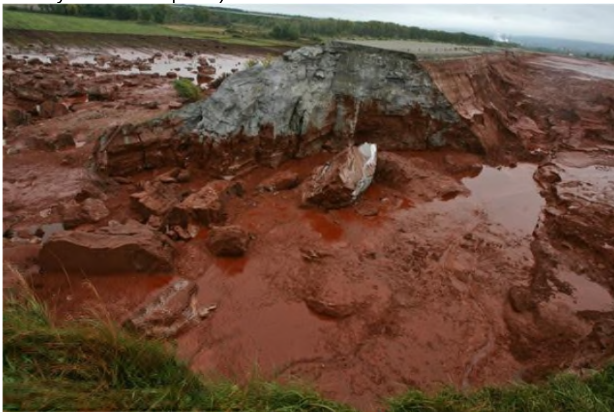
A gát alapjainál 65 m széles. Az összecementálódott kohósalak, közepes szilárdságú betonnak felel meg. Mondja B.Z.
