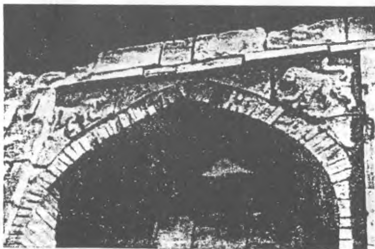
79. ábra. Beleuli. A kapuhomlokzat egy része.
