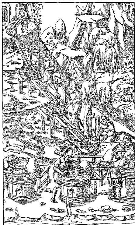
7. ábra: Besztercebányai rostator
